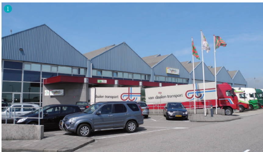
① Versland本社・物流センター外観
